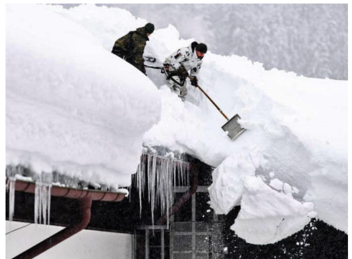
Gewaltige Schneemassen mussten auch von den Dächern der Patengemeinden geräumt werden.
